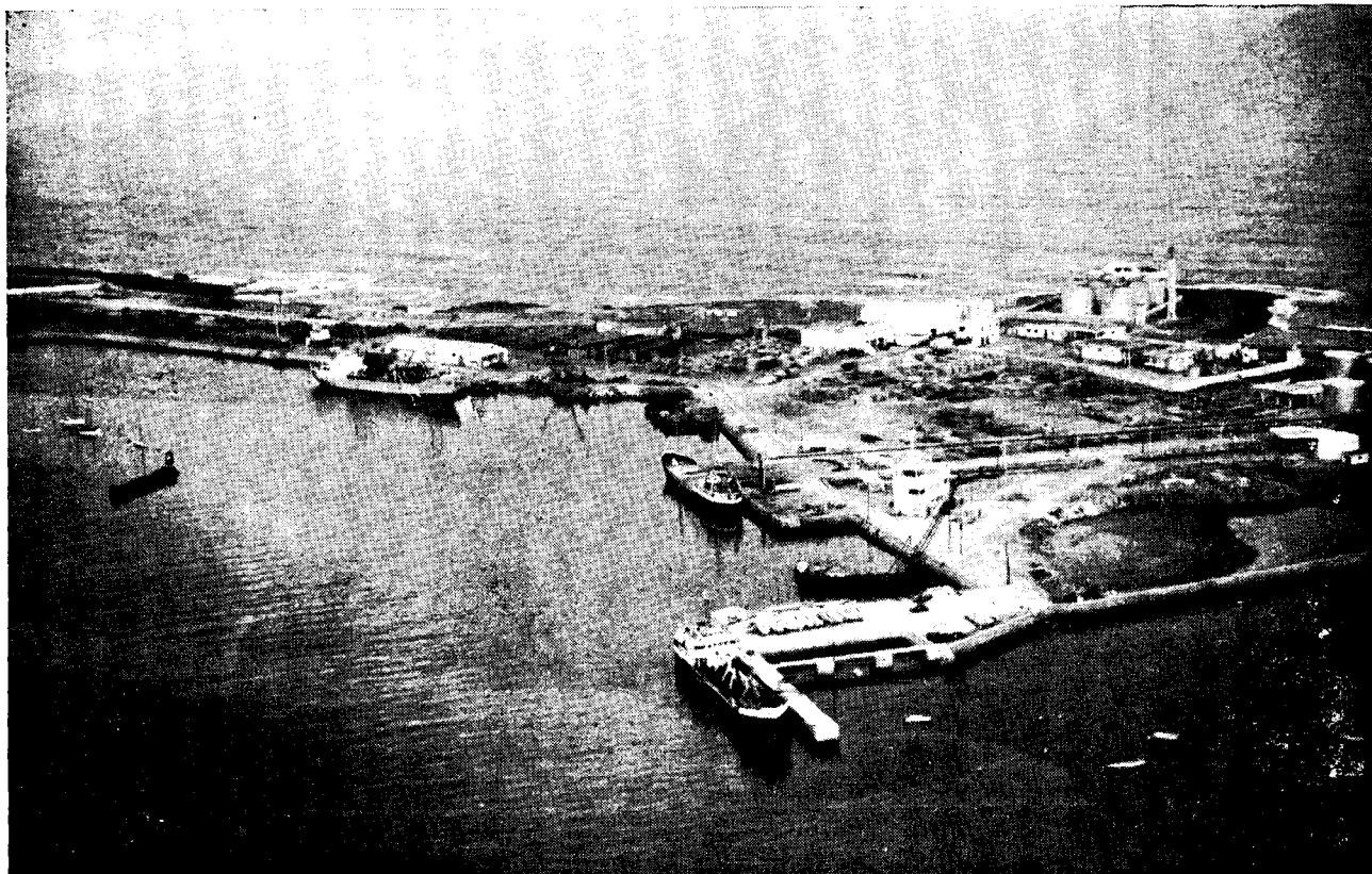
Port de Mohammedia. — Vue aérienne des postes pétroliers
