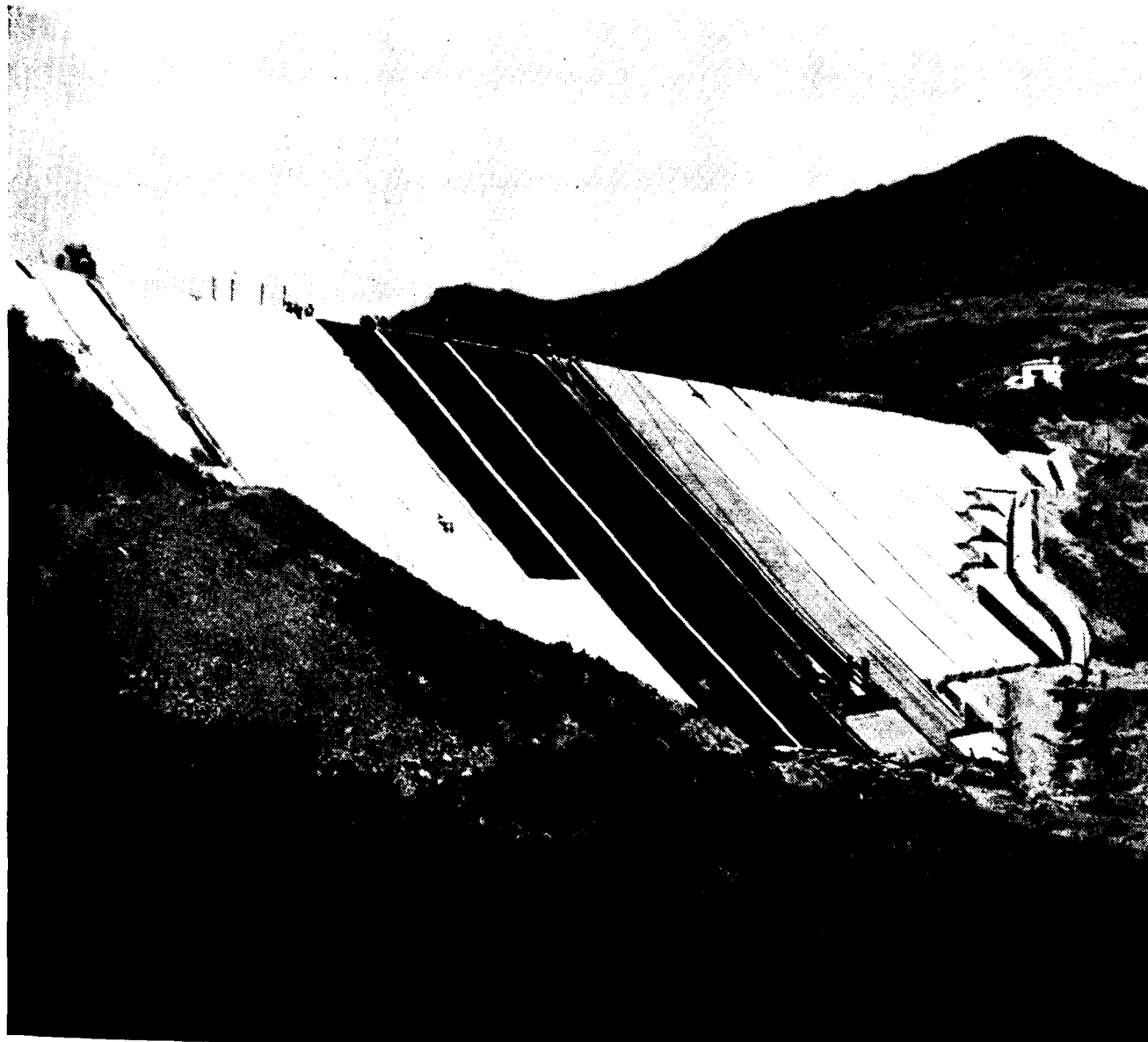
Barrage du Nakla. Vue du parement aval
