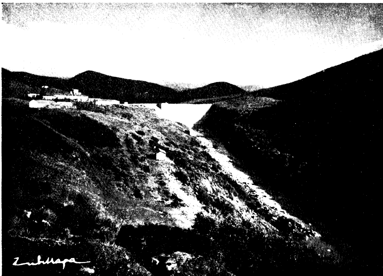
Barrage du Nakhlia. Vue générale prise de l'aval
