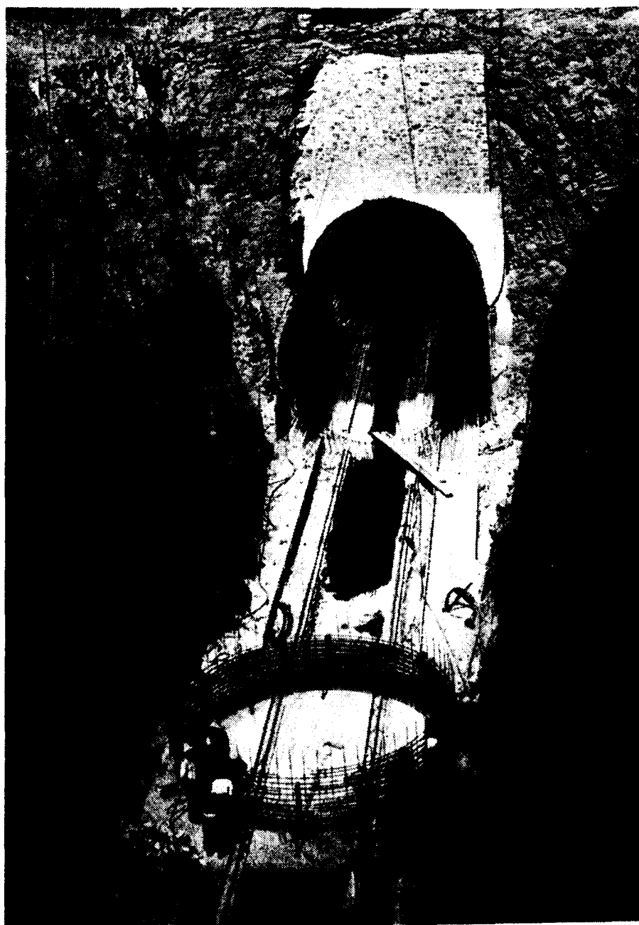
Ferrailage de l'anneau en tranchée aux abords de la chambre des vannes (fenêtre amont)
