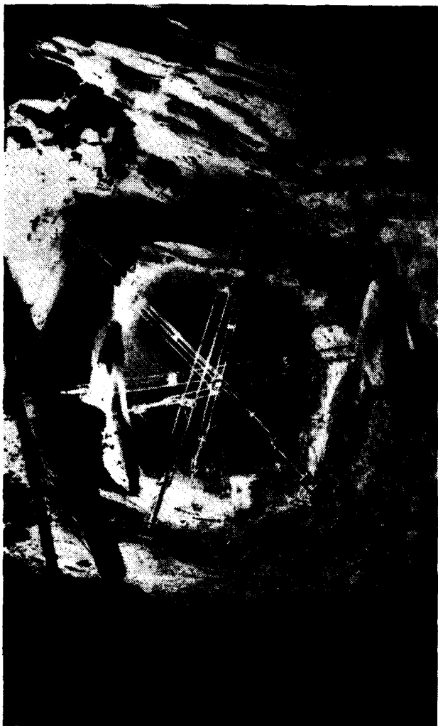
Galerie non revêtue Section équipée de trois témoins Coyne — Mesure perpendiculaire au pendage et à 60° sur le pendage
