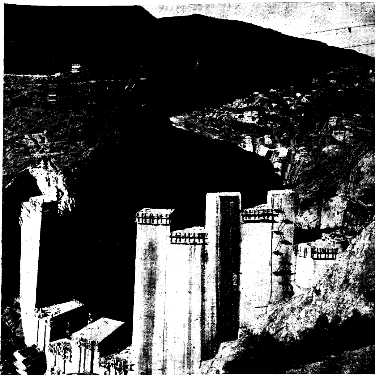
Etat d'avancement des travaux au début de 1952
