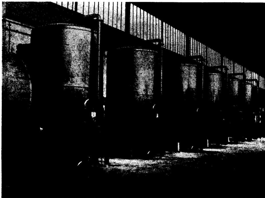
Filtere épurateur pour le traitement des eaux pour la centrale d'Oujda.
