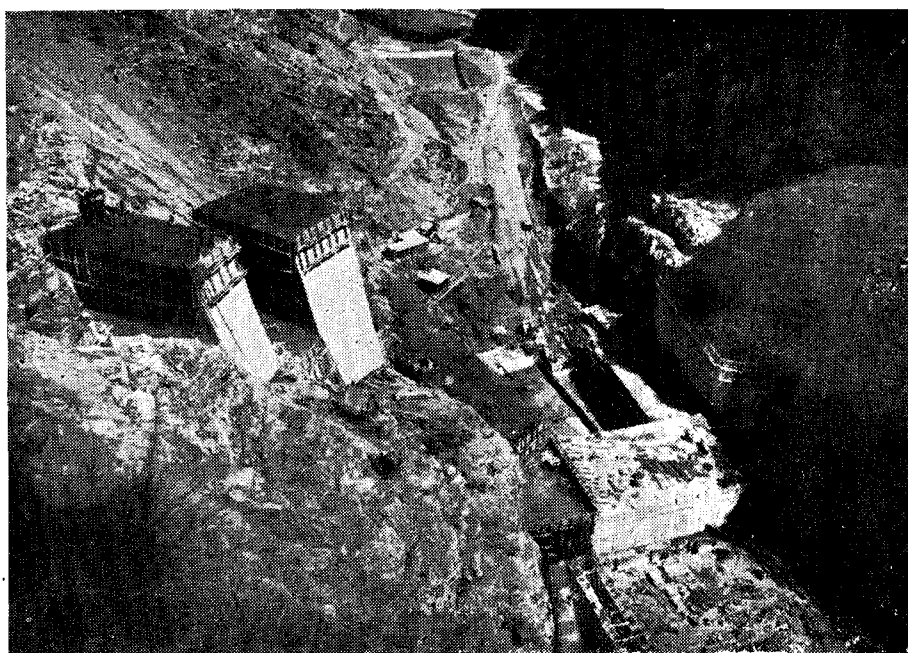
Bin el Ouidane. — Barrage et usine Vue d'ensemble, prise de l'aval, du barrage et de l'usine en cours de bétonnage
