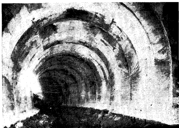
Bin el Ouidane Galerie de dérivation n° 1. Revêtement
