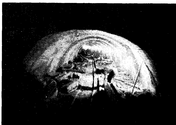
Souterrain S. 6 — Revêtement terminé en calotte
