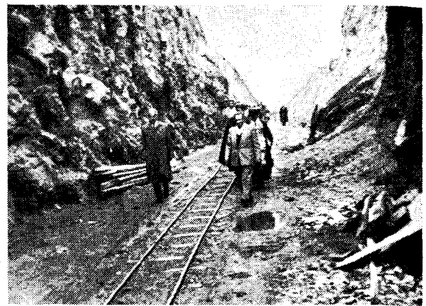
Col du Rhourh P.K. : 33 k. 371 — 27 septembre 1950 Inauguration du percement du souterrain (longueur 1.864 m.) L'entrée du tunnel côté Guenfouda.
