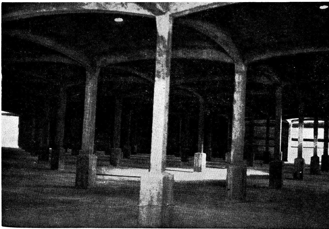
Vue intérieure partielle de la citerne
