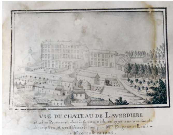
Fig. 2: «Vue du château de Laverdière situé en Provence dessiné en 1795 à Munich et vérifié sur le lieu en 1806 par Louis et Eugène de Machault», dessin au crayon, 1795, Coll. Part.
