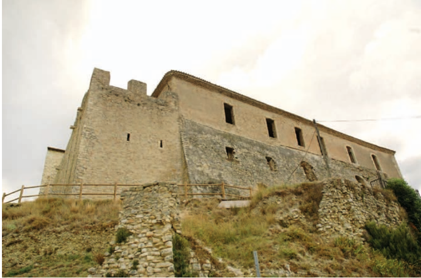
Fig. 12: Vue de la façade sud du château prise depuis le sud-ouest (cl. S. Claude).
