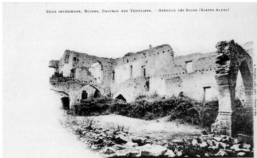
Fig. 6: Cour et vestiges des galeries basses vus depuis le nord-ouest (Coll. Régis Bertrand, photographie non datée).
