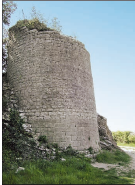
Fig. 8 : La tour circulaire D, définissant l'angle nord-ouest du complexe épiscopal. (Cliché Varano/Laharie)
