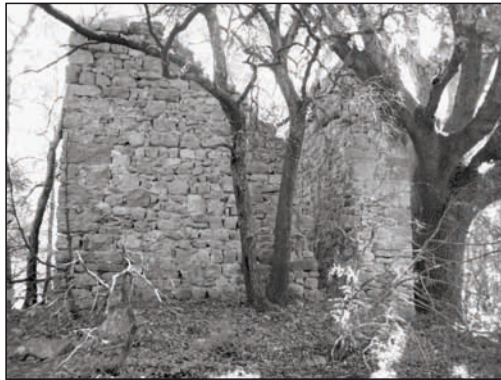
Fig. 5: La tour de Riforan - Un exemple de la pauvreté des maçonneries de certaines de ces fortifications - Entrecasteaux (83) - Cliché Maxime Dadure
