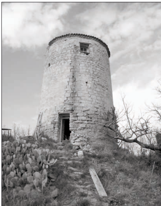
Fig. 6: Le Tourel, un rare exemple de tour privée ronde - La Tour-d'Aigues (84) Cliché Maxime Dadure
