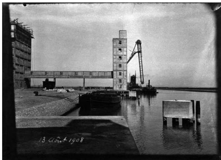
Fig. 8 : Minoterie Gautier (Port-Saint-Louis-du-Rhône, 1906-1908), photographie de chantier prise le 13 août 1908, accompagnée de la légende suivante « Le garage et les silos sont terminés. Les grands silos n'ont pas encore été chargés. Les petits silos le sont depuis le 15 juillet. La passerelle n'a pas fléchi », AD BDR 6 S 903
