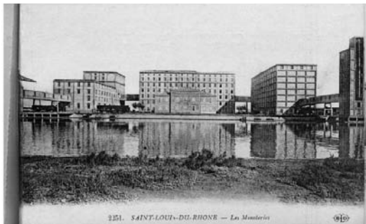
Fig. 5 : Minoterie Gautier (Port-Saint-Louis-du-Rhône, 1906-1908), AD BDR 6 Fi 5583/9
