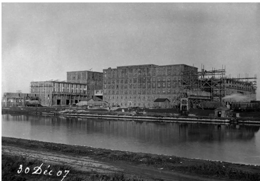
Fig. 7: Minoterie Gautier (Port-Saint-Louis-du-Rhône, 1906-1908), photographie de chantier (30 décembre 1907), AD BDR 6 S 903
