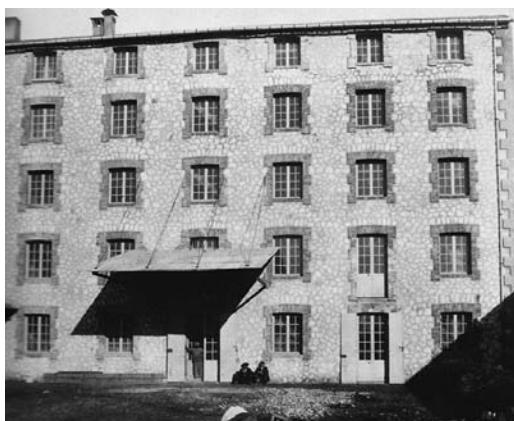
Fig. 9: Minoterie Brunet (Marseille, 1905, arch.: Callamand), cliché tiré de la brochure éditée par l'entreprise Julien frères en 1938 pour présenter leurs travaux (Marseille, 1938, coll. part.)
