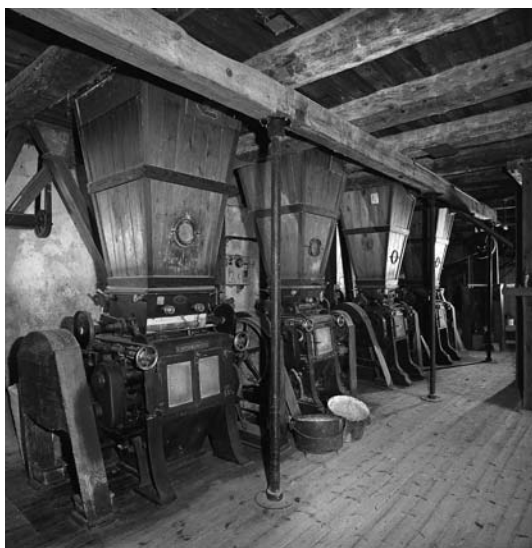
Fig. 5: La salle des broyeurs de la minoterie de La Mure-Argens. (© Région Provence-Alpes-Côte d'Azur - Inventaire général - Marc Heller, 2006)
