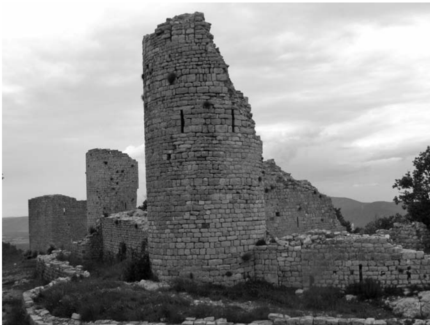
Rougiers enceinte protégeant le château conservée en élévation. (Cl. Y. Codou)
