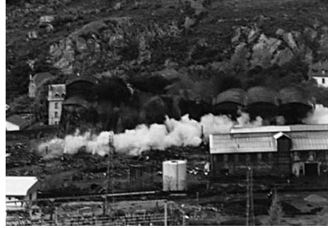
Ill. 6: Démolition de l'usine à coke en 1985. (Collection Pogneaux.)
