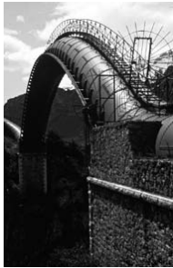
Ill. 1: Siphon des gorges de la Durance, construite par Planche en 1908 afin de faire rejoindre les eaux de la Gyronde et celles de la Durance : labellisé « Patrimoine du XX e siècle » en 2007. (Photo Mairie de L'Argentière)
