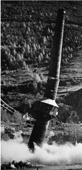
Ill. 5: Démolition de la cheminée de la fonderie en 1985. (Collection Pogneaux.)
