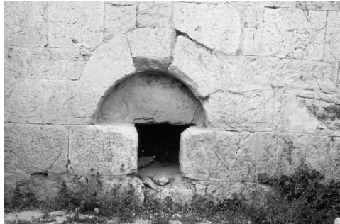
fig; 10 : Mur gouttereau sud, extérieur de la deuxième travée : niche (« enfeu-ossuaire » ?) (cl. A. HARTMANN-VIRNICH, 1998).
