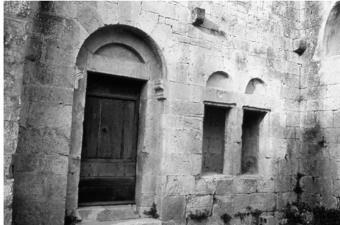
fig. 11 : Mur gouttereau sud, extérieur de la troisième travée : porte dite « des convers » et armarium.
