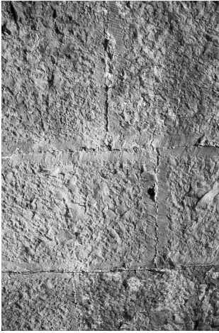
fig. 3 : Parement de pierre de taille (intérieur du chevet principal) (cl. A. HARTMANN-VIRNICH, 1998).
