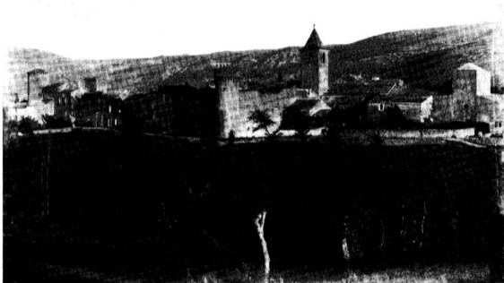
7 - Vue ancienne de l'enceinte de Sainte-Eulalie. A l'extrême droite la tour des Quarante, dans son prolongement des bâtiments de service de la commanderie, puis l'église avec son clocher. A gauche le front nord de l'enceinte du village avec des éléments du parapet conservés.
