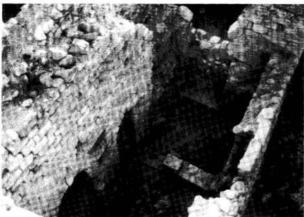
Fig. 4 : Croisillon sud du transept vu du nord-est. A droite, mur de refend est-ouest ; en haut, porte d, à gauche arcs du mur sud et porte h.
