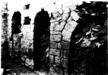
Fig. 3 : Ares sur le mur sud du transept. A gauche, la porte h.
