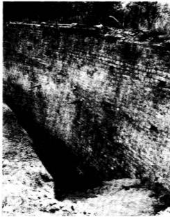
Figure 3 : La Plate-Forme : vue intérieure du mur de soutènement sud après fouille.
