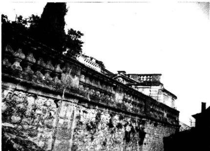
Les terrasses et le couronnement de la perspective Est, vus depuis l'escalier (photo prise en 1930).
