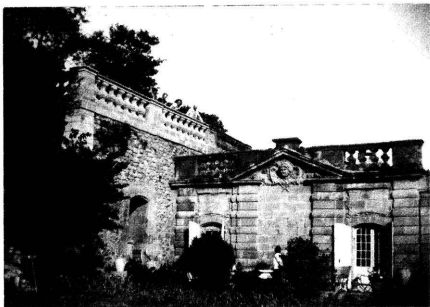
La perspective à l'extrémité Est de la terrasse principale (photo prise en 1930 : l'ensemble est plus dégagé qu'aujourd'hui).
