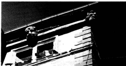
Dessus-de-porte, au second étage du château.
