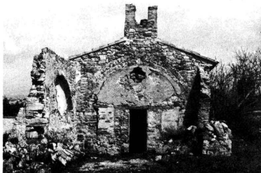
Fig. 5 : Chapelle en l'état actuel : entrée triomphale et porche moderne.
