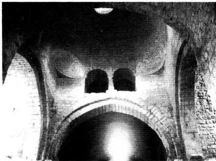
SAINT-PIERRE-DE-RUOMS : La coupole sur trompes en cul de four (XI e s.)
