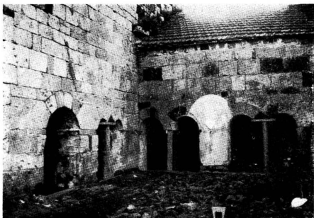
MAZAN. — Le cloître, angle S.-O. en cours de dégagement
