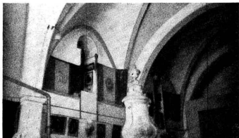
Fig. 4. — Ancienne église des Minimes de Toulon (nef, côté sud).
