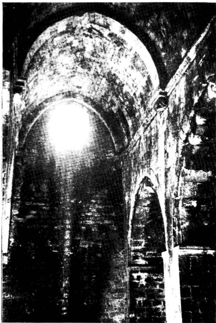
Sainte Apollinaire de Puimisson. Parties hautes de la nef.
