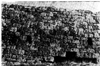
Fig. 4. — Château de Barry Vue extérieure avec deux meurtrières
