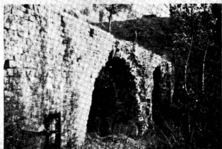
II. Pont aqueduc à 2 arches. (Ouvrage N° 2)
