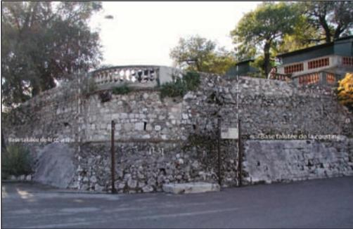
Fig. 10 : Arrachements à l'angle nord-est de l'enceinte palatiale, situant précisément la position de la tour Cadri [T.5] et conservant des vestiges de la base talutée de la courtine. (Cliché Éric Guilloteau)
