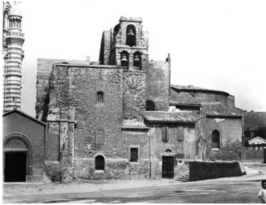
Fig. 4 – La Major après démolition des deux travées occidentales et de la chapelle de la Vierge, état intermédiaire entre 1855 et 1895 où une entrée sur la gauche de la façade sud permet d'accéder à l'édifice par l'ouest. Photo François Roustan en 1890, Médiathèque de l'Architecture et du Patrimoine, Paris, Planothèque, carton vert F2 - Marseille « La Major » – Col : ROUSTAN, cote 12475/1903, pl. 27 (cliché repro. F. Valette - Ministère de la Culture (France), 1994).
