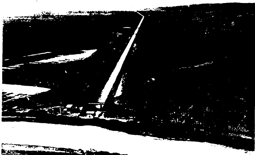
Canal émissaire du réseau d'assainissement de la plaine de la Mabtouha
