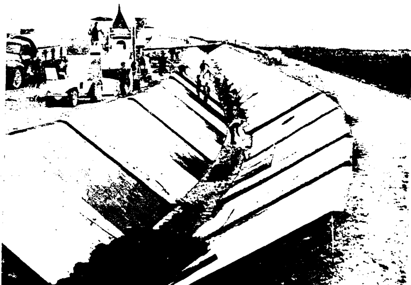
Grand canal de Taullierville — Chantier de pose de revêtement (mars 1955)
