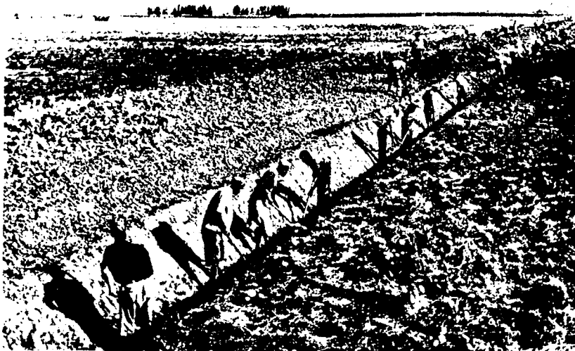
Réalisation de travaux d'assainissement à main d'homme dans le secteur de Béjaoua
