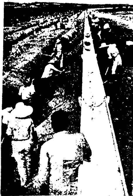
Pose de canaux d'irrigation
