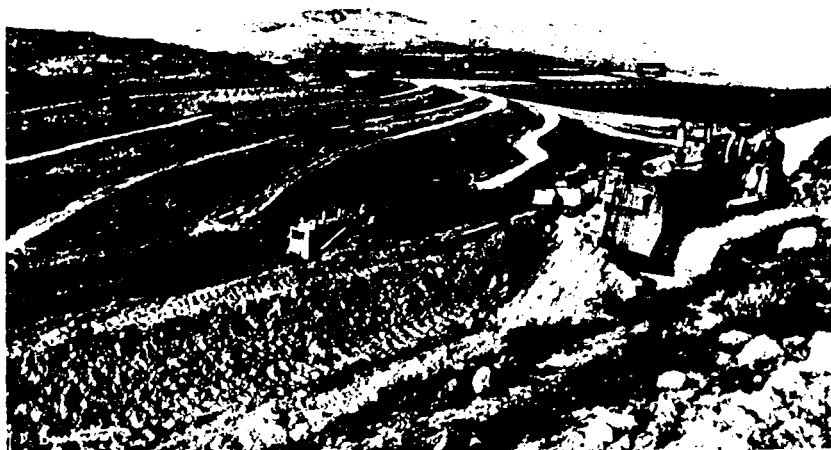
Chantier d'exécution de terrasses aux engins mécaniques dans le Djebel Nahli
