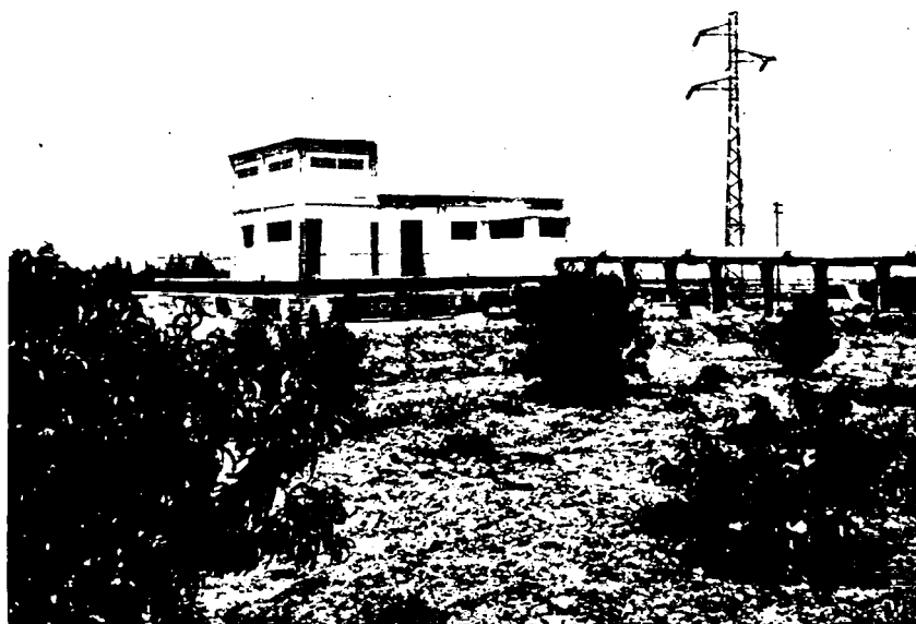
Station de pompage du secteur de Béjaoua
