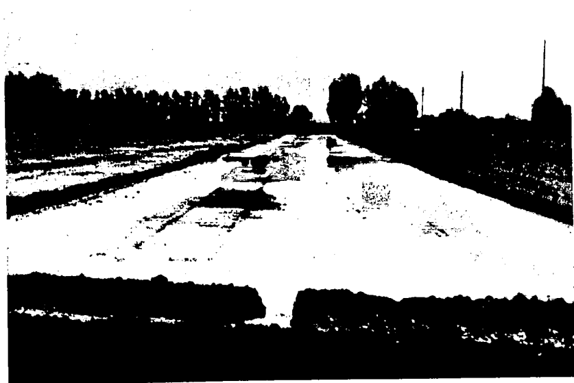
Fig. 2. — Calant mis en eau
