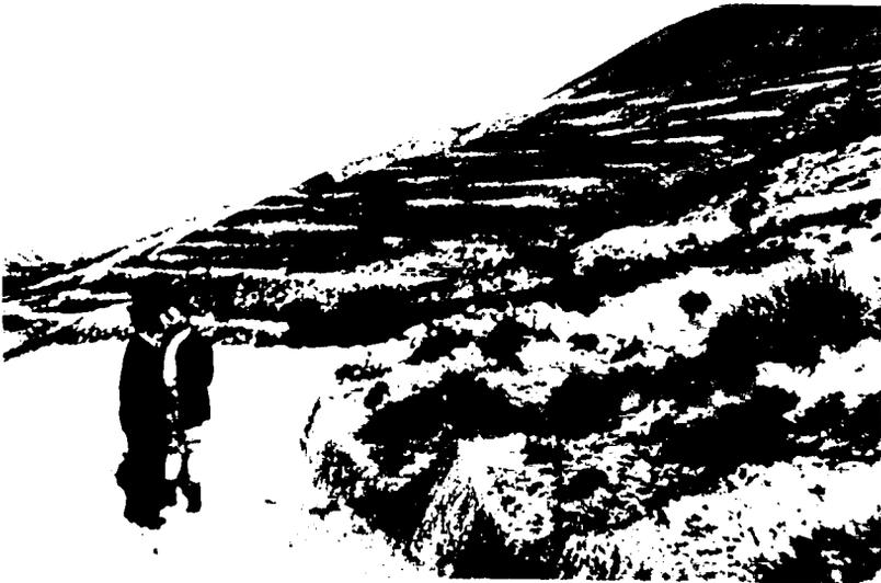
Restauration d'un versant montagneux au moyen de banquettes d'infiltration
