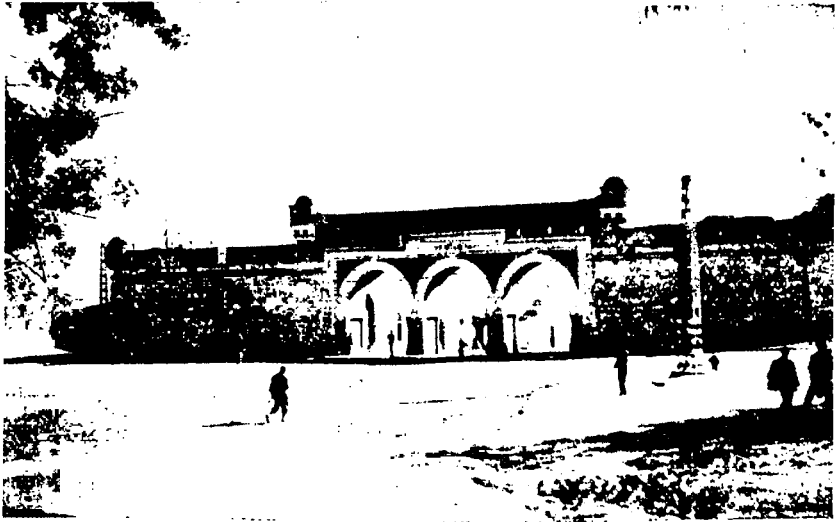
Fig. 3. — TUNIS — Bab Bou-Saâdoun, porte à trois baies qui a remplacé l'ancienne porte à baie unique
