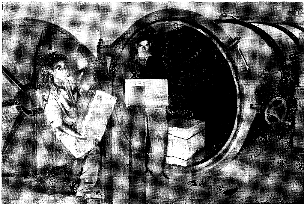
Un tank de désinsectisation (Photo O.T.U.S.)
